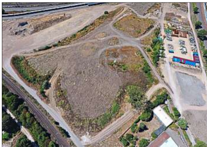
Der im Gleisdreieck gelagerte Erdaushub sorgte seit Jahren für Streit zwischen der Regensburger Stadtverwaltung und dem Bauträger Ferdinand Schmack. Foto: Lex/Archiv
